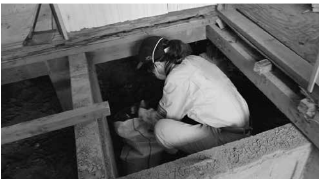
床下の泥出し
